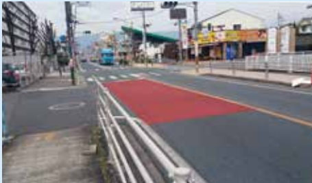
交差点注意喚起のカラー舗装施工 (イトーピアマンション前)
