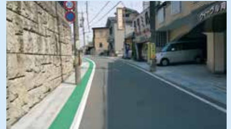
側溝溝蓋設置及びカラー舗装施工 (府道向日善峰線)
