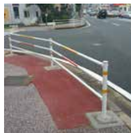
府道中山稻荷線に 自転車横断防止柵 を設置。 自転車が歩道の段 差で転倒するのを 防止。
